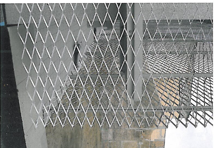
Schnitt mit vorgehangler Fassade, Rampe und Vordach; Detail des Streckgitters (Maschenweite 30 x 10 cm). In das Sockelgeschoss auf der Spree-seite ist das Architektur-büro gezogen Detailschnitt im Maßstab 1:150, Schnitt 1:500; Foto oben: SP
